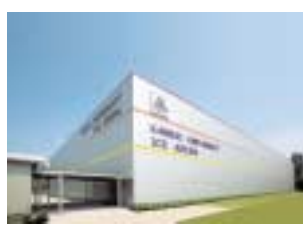
号館の一部を解体し、その跡地に鉄筋コンクリート造した。その跡地に鉄筋コンクリート造四階建、延床面積約三千八百平方メートルの建物 建築して既存の以文館に設備も備わります。
