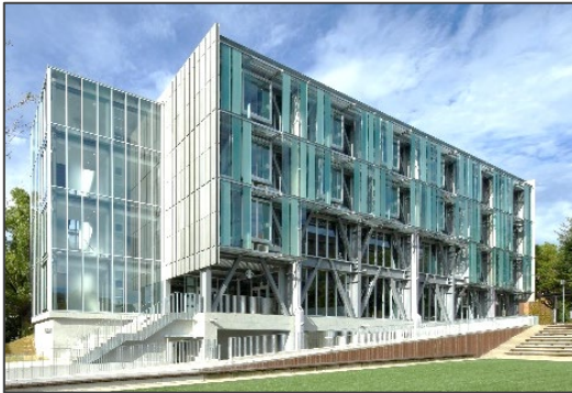
<関西大学イノベーション創生センター外観>
